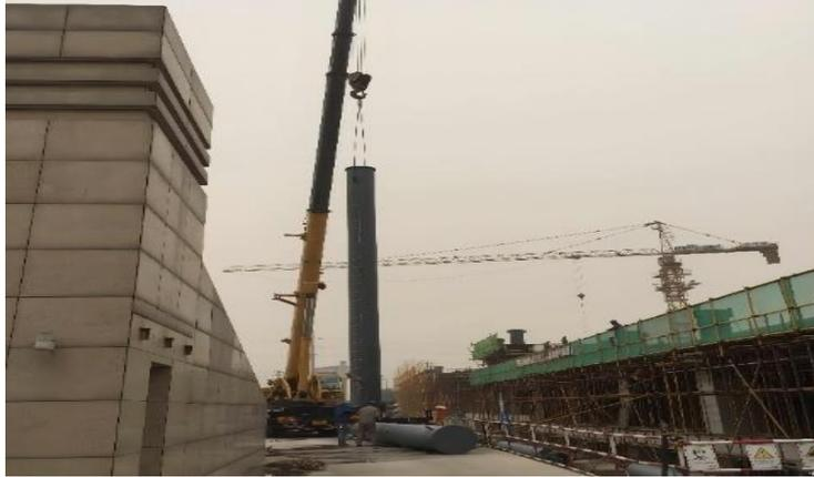
图 1 常见钢柱的吊装示意图
