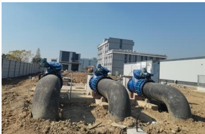
图 3 某站调蓄水池及雨水泵站
