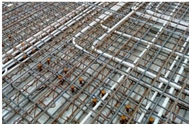
图1 钢筋桁架楼承板
